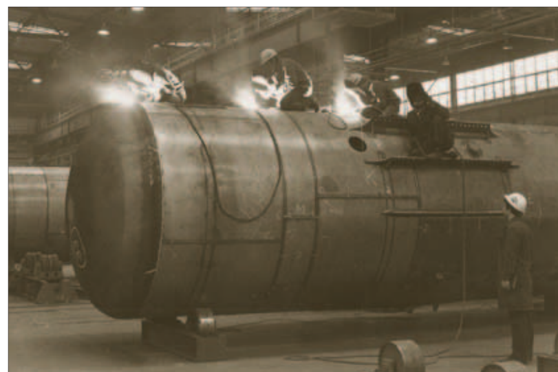
Ciężka praca w Przedsiębiorstwie Robót Montażowych Przemysłu Chemicznego „Montochem” w Kępnie. APK, Zbiór fotografii i pocztówek
