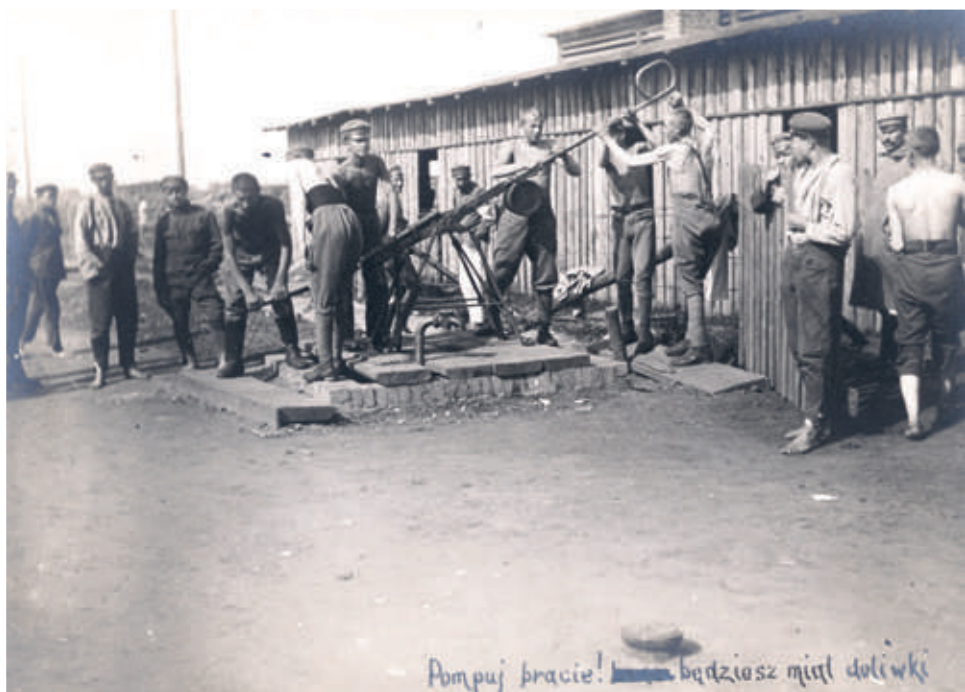
41. Pompowanie wody. MOZK, sygn. H-2516
