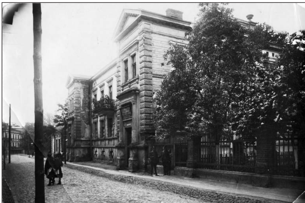
16. Budynek Komendy Powiatowej PP w Kaliszu przy ul. Niecałej, lata 30. XX w. APK, Spuścizna Tadeusza Martyna z Kalisza, sygn. 1784
