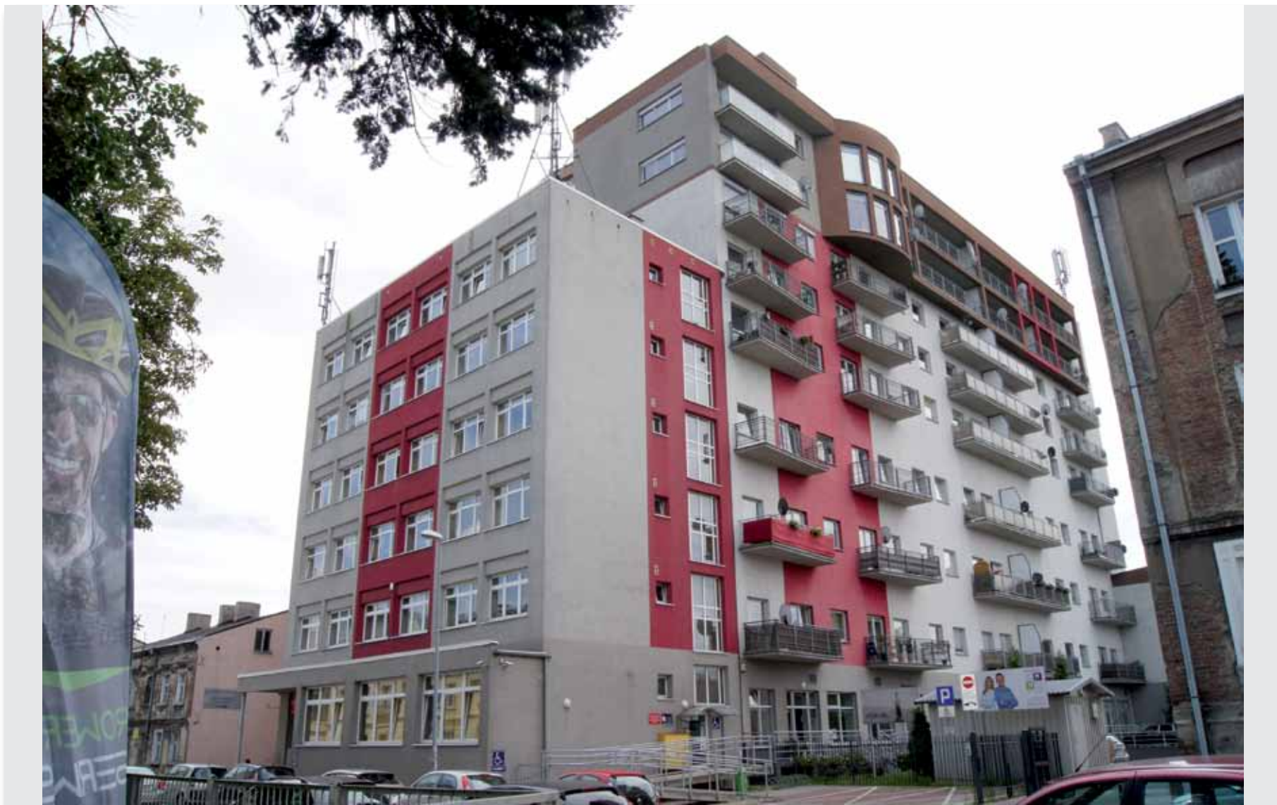
28c. Na bazie budynku Zakładów Przemysłu Odzieżowego „Kalpo” (przy ul. Dobrzeckiej 18) powstał apartamentowiec, którego parter zajmują zakłady handlowe i usługowe oraz Miejski Zarząd Budynków Mieszkalnych
