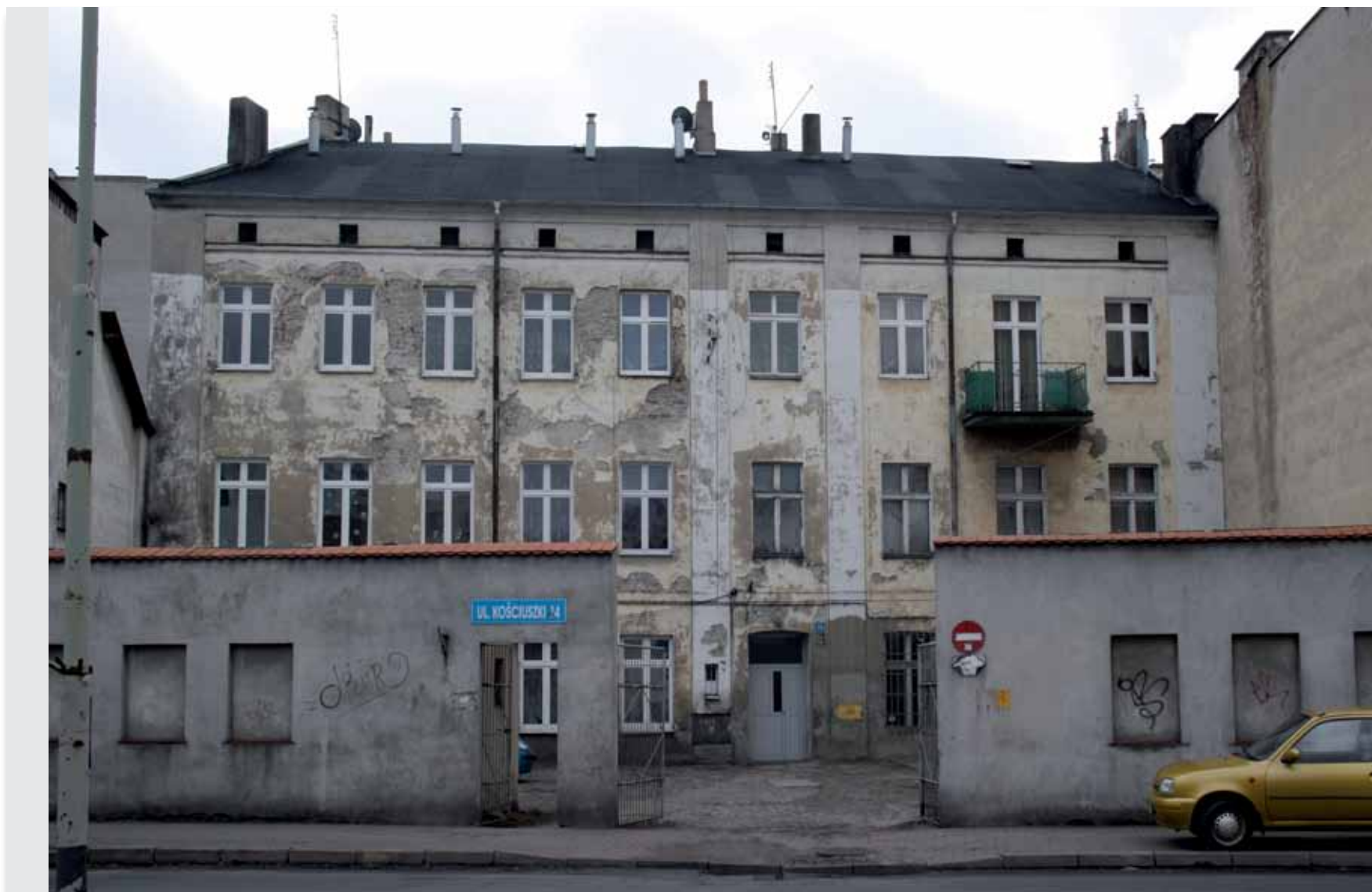
13a. Budynek pofabryczny pełni dzisiaj funkcję kamienicy mieszkalnej (obecnie ul. Kościuszki 14)
