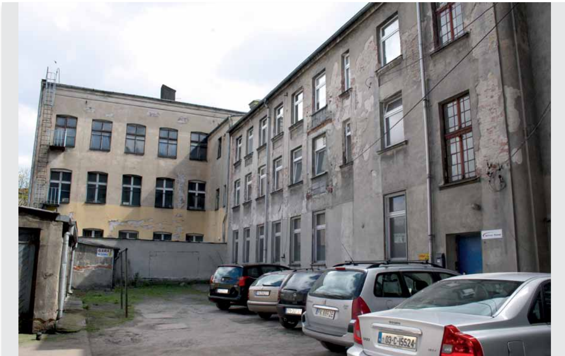
28b. Budynek po Mechanicznej Fabryce Haftów i Koronek Szlama Bułki, a po II wojnie światowej Państwowych Zjednoczonych Fabrykach Konfekcyjnych (obecnie ul. Pułaskiego 18)
