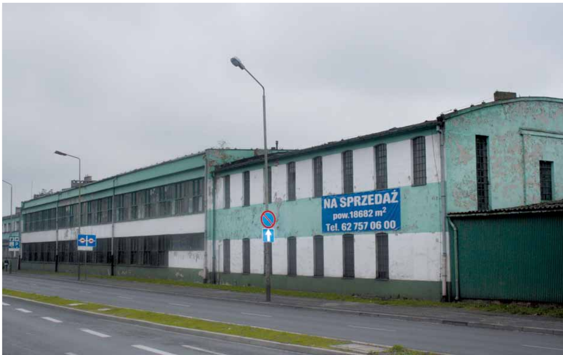
57a. Obiekty po „Orkanie” (obecnie ul. Złotej 20a) jeszcze do niedawna były użytkowane przez firmę Teknia Kalisz sp. z o.o., zajmującą się produkcją i montażem części i zespołów dla przemysłu motoryzacyjnego (tutaj widok od al. Wojska Polskiego)
