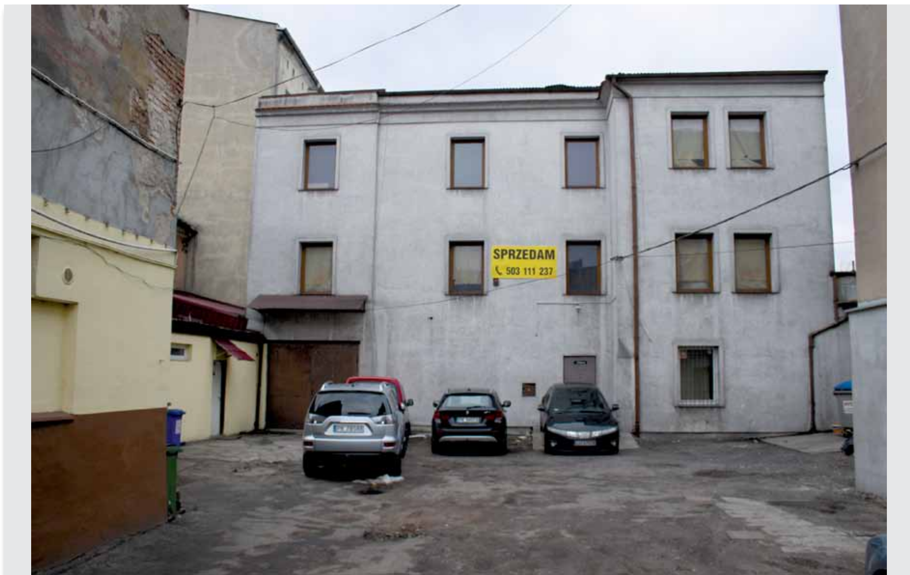
26a. Budynek po zakładzie Maurycego Friedego dzisiaj pełni funkcje usługowo-mieszkalne (obecnie ul. Babina 19)
