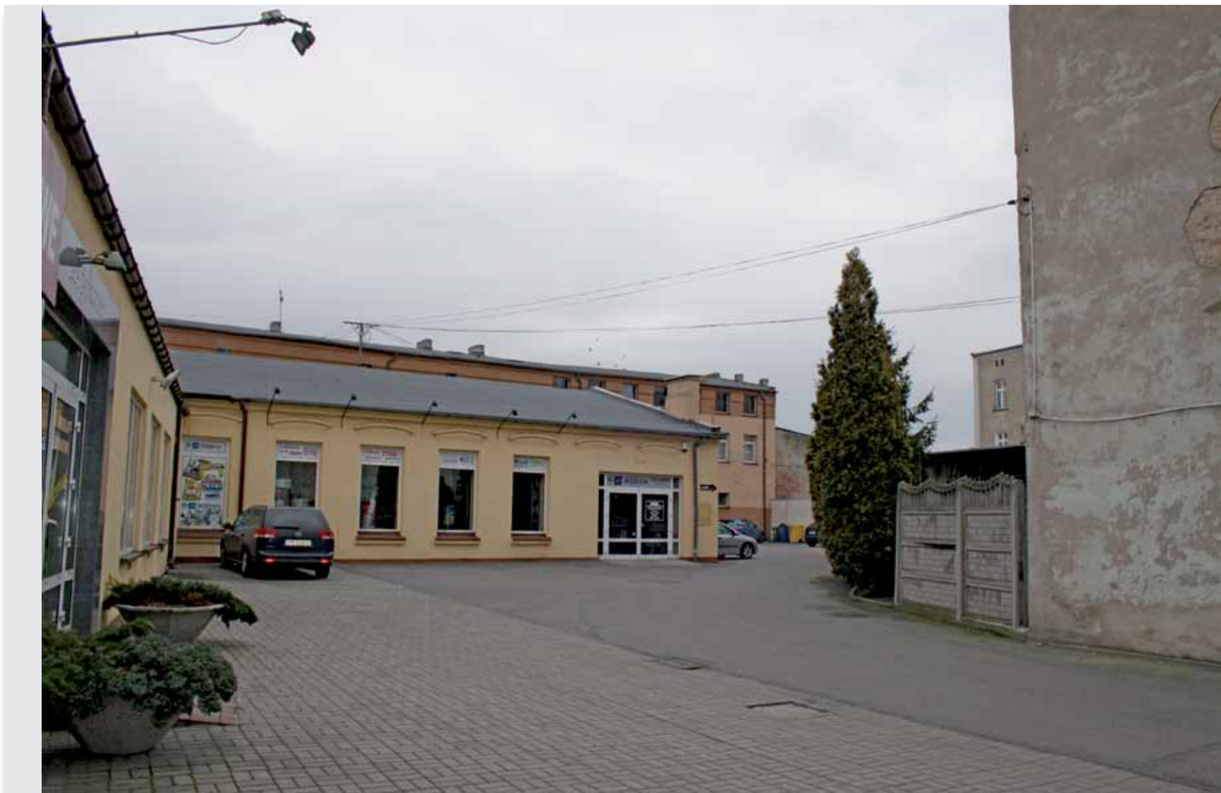
11b. W budynku po fabryce Hermana Górnego mieszczą się dzisiaj instytucje handlowe (obecnie ul. Piskorzewie 17a)
