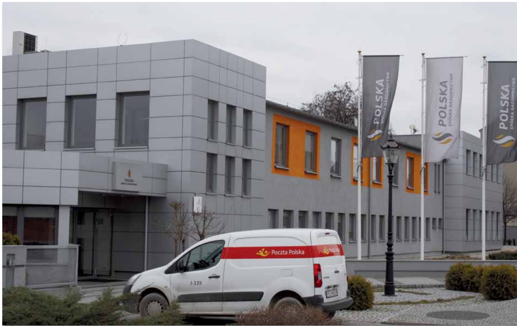
78b. Obecnie w budynkach dawnej Gazowni Miejskiej mieści się Polska Spółka Gazownictwa sp. z o.o. Oddział w Poznaniu Zakład w Kaliszu przy ul. Majkowskiej 9
