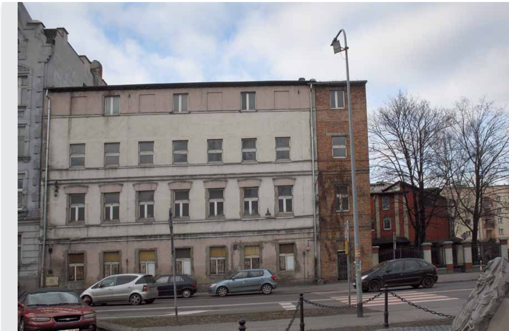
19a. Wielokrotnie przebudowywany budynek pofabryczny po Fabryce Wyrobów Dziaonych, dzisiaj opuszczony (obecnie ul. Kopernika 3)
