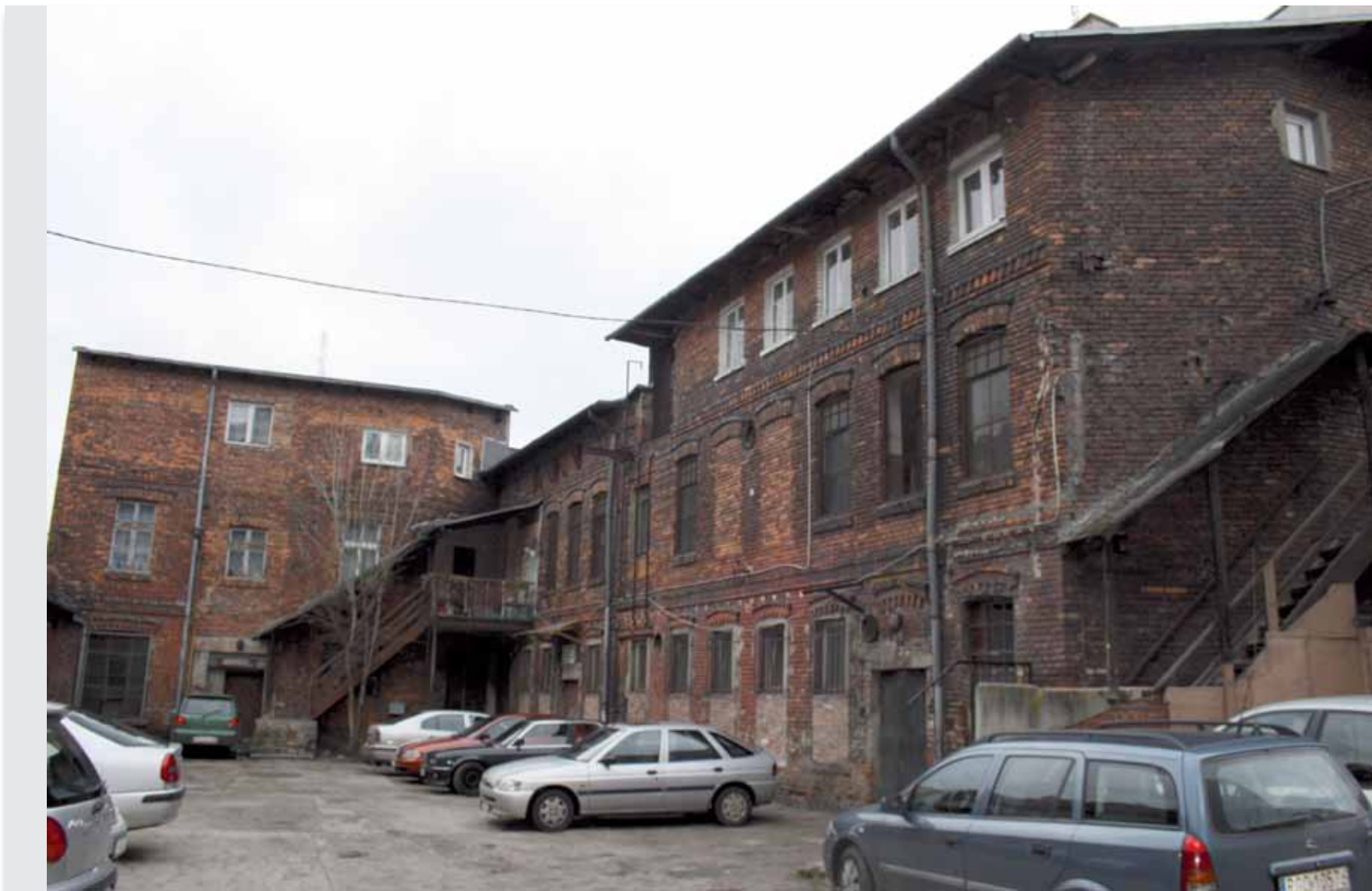
3a. Dzisiaj obiekty pofabryczne przy pl. Kilińskiego 2 są opuszczone
