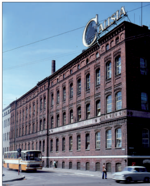
22. Budynek Fabryki Fortepianów i Pianin „Calisia” w Kaliszu. Fot. J. Podziewski, 1977 r., NAC, Krajowa Agencja Wydawnicza, sygn. 45-12-174
